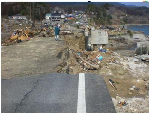
▼写真③(鳥谷坂橋A1:橋台背面盛土崩落)
