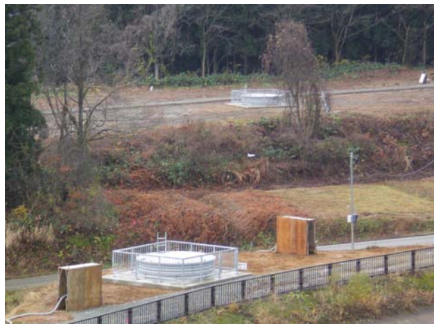
集水井 W-5、W-6 完成状況
