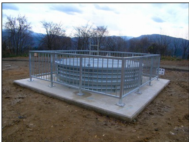
集水井 W-6 完成状況
