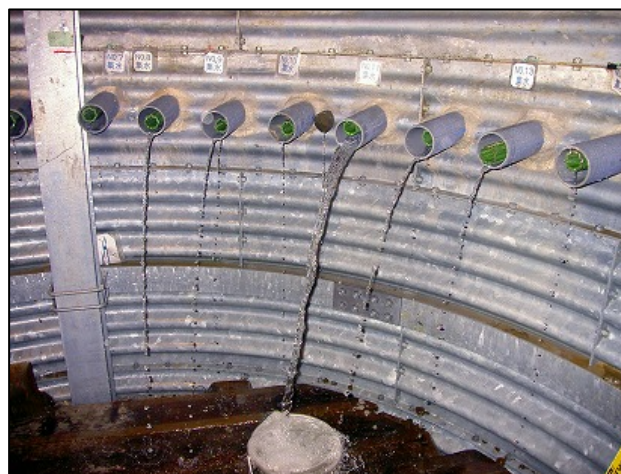
集水井 W-6 集水状況
