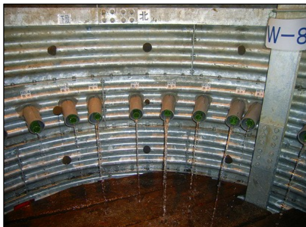
集水井 W-8 集水状況
