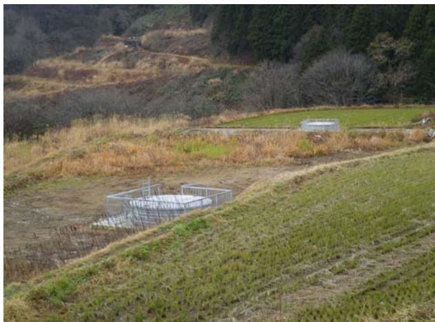
集水井 W-4、W-7 完成状況
