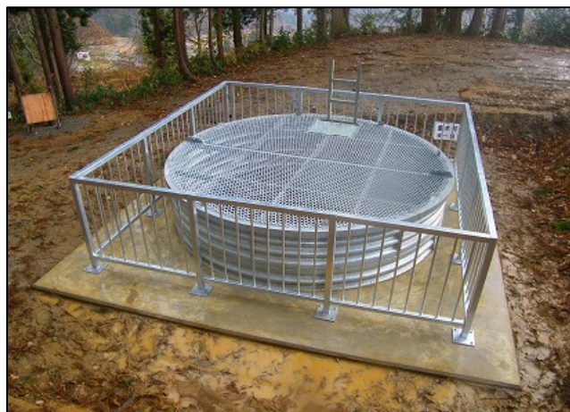
集水井 W-8 完成状況
