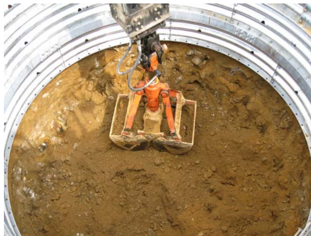
集水井掘削状況
