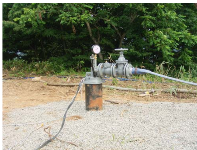
ディープウエル作業完了(排水中)
