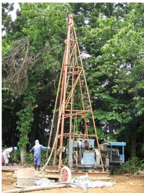
ディープウエル掘削作業
