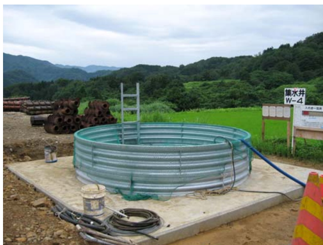
集水井掘削完了
