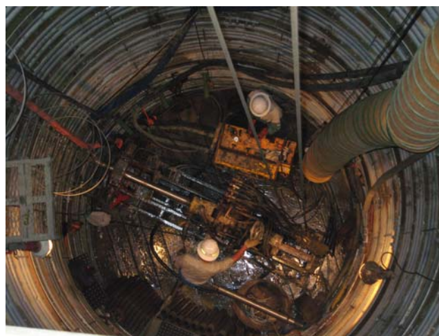
集水井内部ボーリング作業
