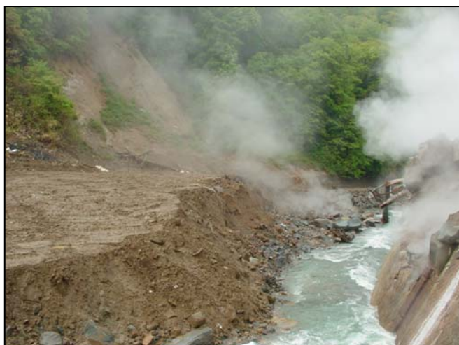
河道整正状況(通水能力向上)
