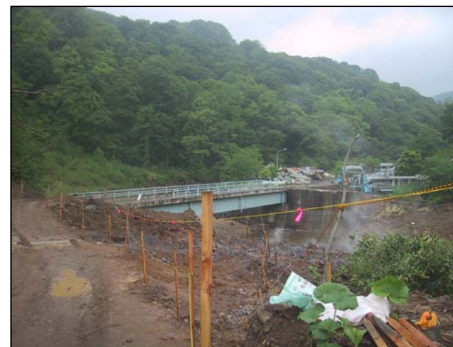
配管撤去状況
