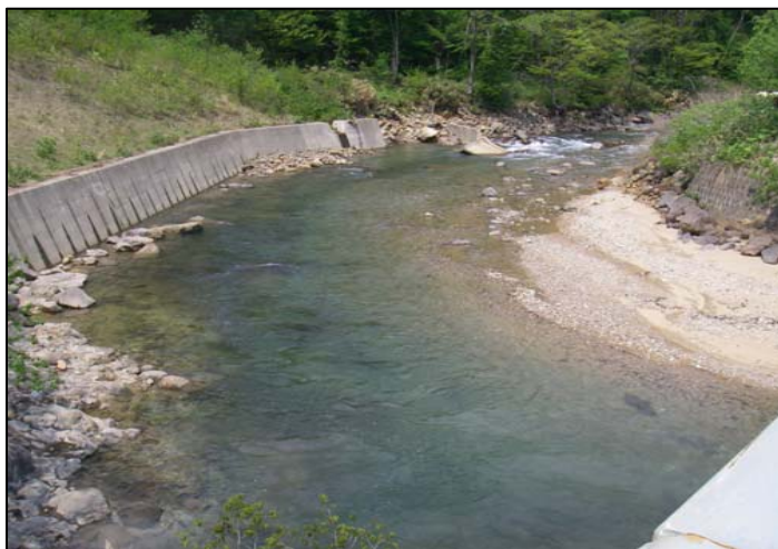
せき上げ解消状況
