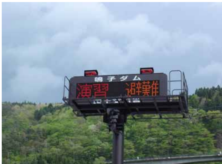
平成19年度 ダム管理演習 放流警報表示板情報提供訓練
