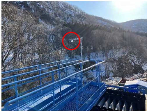
監視カメラの設置 (原水槽用)
