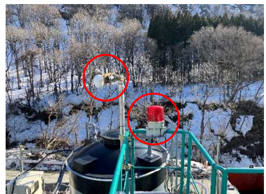
警告灯の設置および 監視カメラの設置 (原水槽用)
