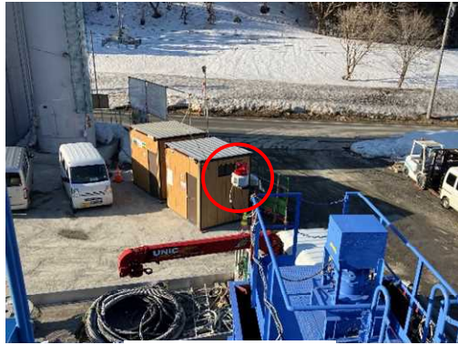
警告灯の設置
