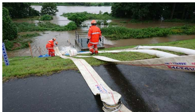
排水作業の事例
