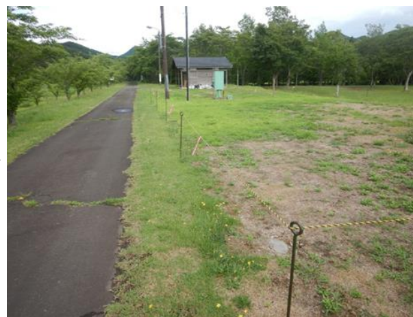
【七ヶ宿ダム休養公園】 運動広場トイレ付近の浄化槽点検用マンホールの蓋の殆どがコンクリートブロックに置き換わっており、経年劣化により窪みができていたため、トラロープにより立ち入り禁止とする応急措置を行いました。
