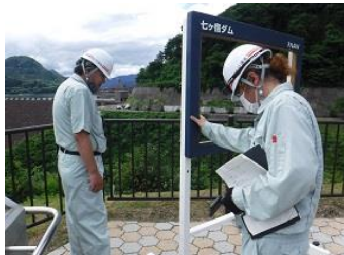
石畳、看板及び転落防止柵等 点検状況 (七ヶ宿ダム展望公園)
