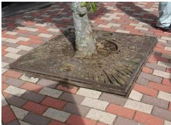
【七ヶ宿ダム展望公園】 樹木保護蓋が浮き上がり段差が生じていたため、応急措置として危険性の表示（着色）を行いました。
