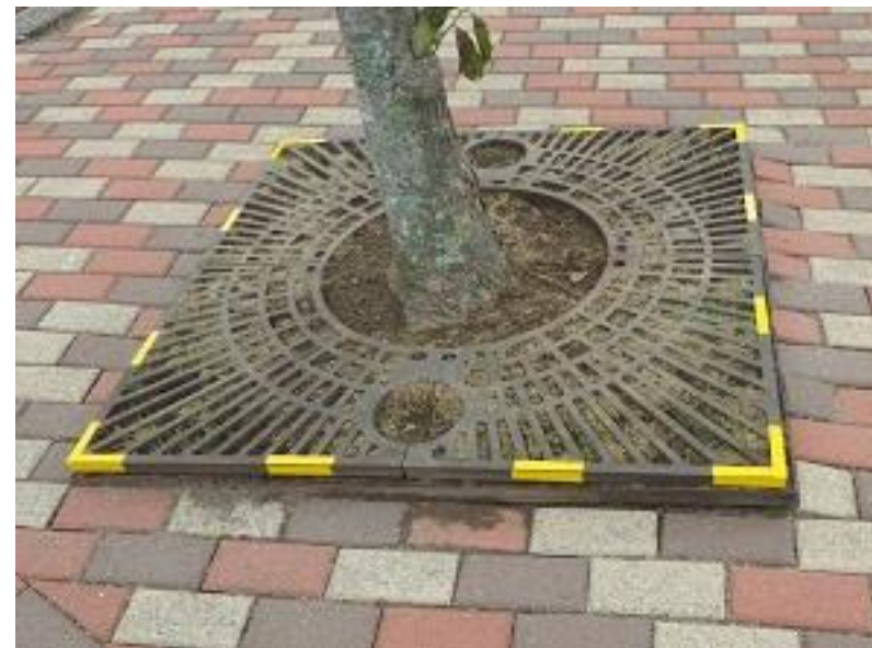
【七ヶ宿ダム展望公園】 樹木保護蓋が浮き上がり段差が生じていたため、応急措置として危険性の表示（着色）を行いました。
