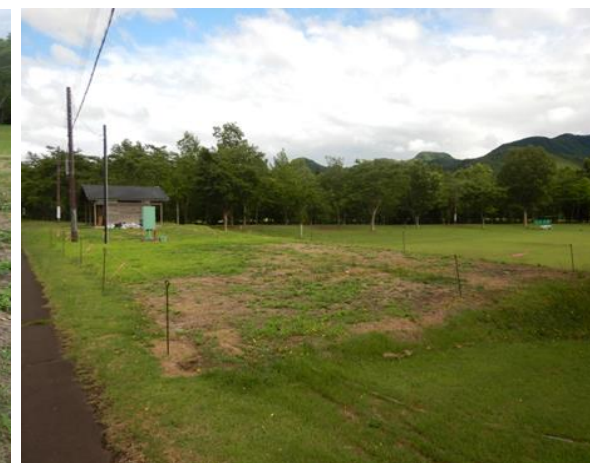
【七ヶ宿ダム休養公園】 運動広場トイレ付近の浄化槽点検用マンホールの蓋の殆どがコンクリートブロックに置き換わっており、経年劣化により窪みができていたため、トラロープにより立ち入り禁止とする応急措置を行いました。
