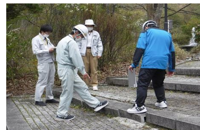
階段・石畳 点検状況(材木岩公園)
