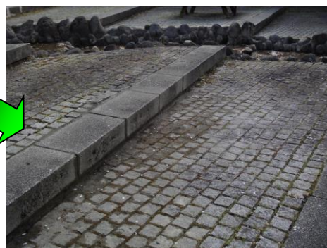
【材木岩公園】 階段や石畳の破損していた箇所を修繕しました。
