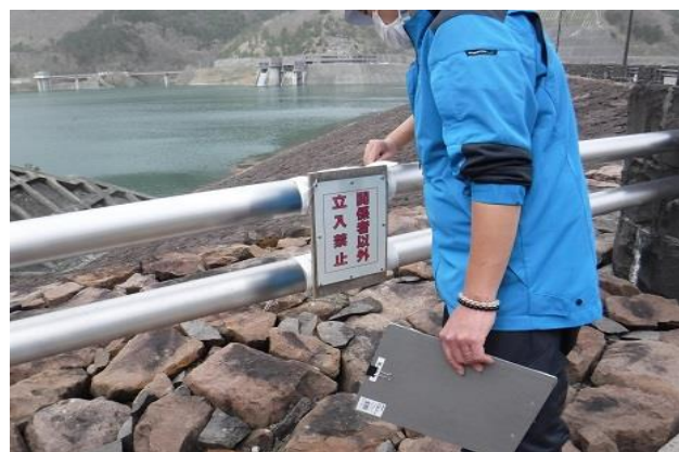
看板及び転落防止柵等 点検状況(ダム右岸公園)
