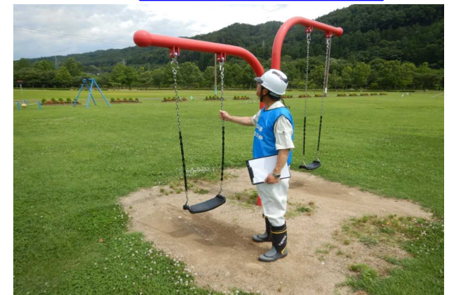
立入禁止柵、遊具等 点検状況 (七ヶ宿ダム自然休養公園)
