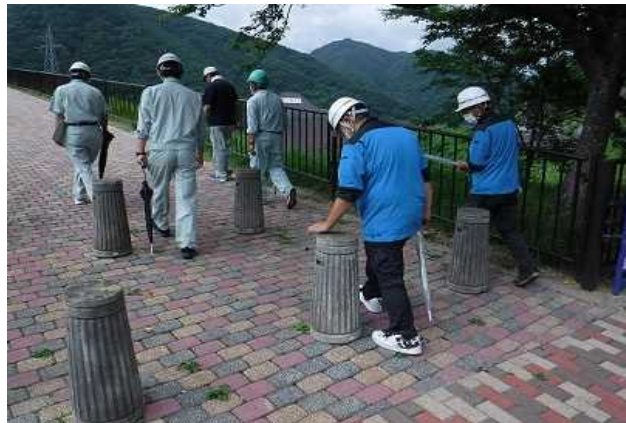
看板及び転落防止柵等、点検状況 (七ヶ宿ダム展望公園)
