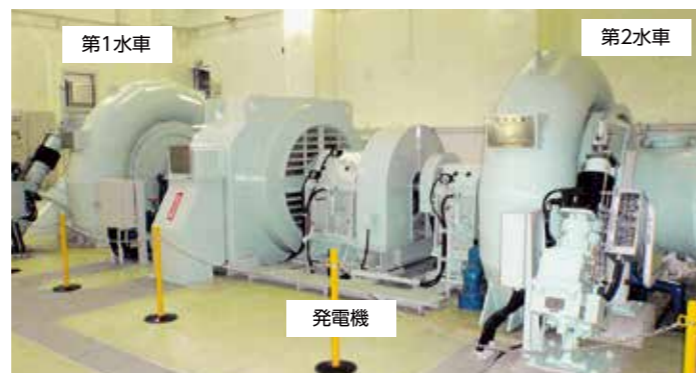
※1 3,980×0.9(効率)=3,582=3,600KW ※2 一帯あたりの電力消費量4MW/年として計算 ※3 水車2台を同時運転した場合は効率上がる
