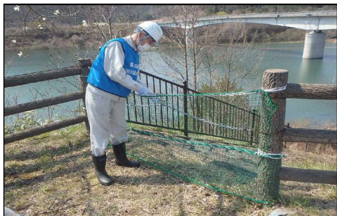
立入禁止施設 点検状況(七ヶ宿公園)
