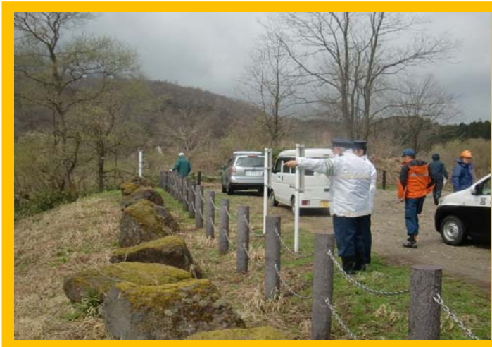
貯砂ダム(荒雄河川公園)点検状況
