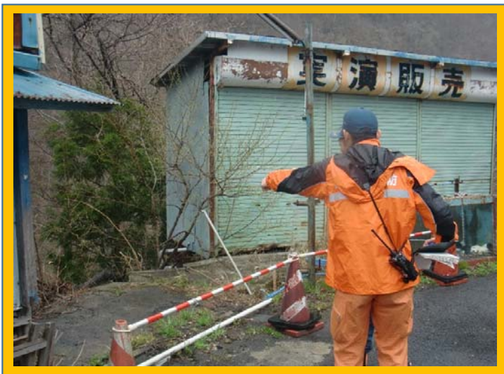
管理用道路点検状況
