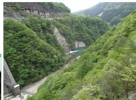
ダムからの眺め（下流）
