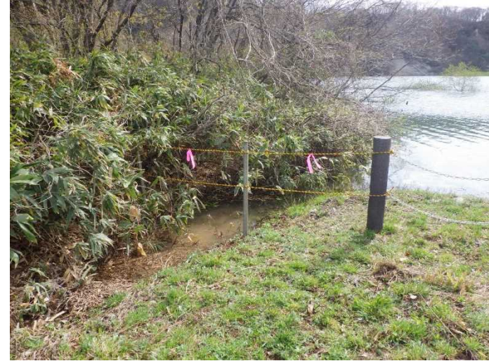
①貯砂ダム(立入禁止柵端部にロープ張を追加)
