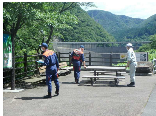
点検状況（堤体管理用通路）
