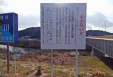
43. 及川橋下流(左岸)警報板 ダム下流61.0km(左岸)地点
