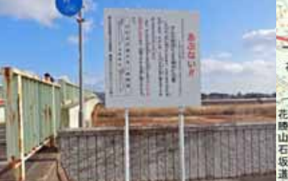
40. 涌谷大橋下流(右岸)警報板 ダム下流54.2km(右岸)地点
