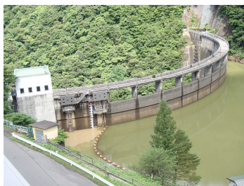
鳴子ダム貯留状況
