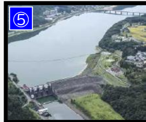
御所ダム(盛岡市、雫石町) 昭和56年10月完成(完成後40年目)
