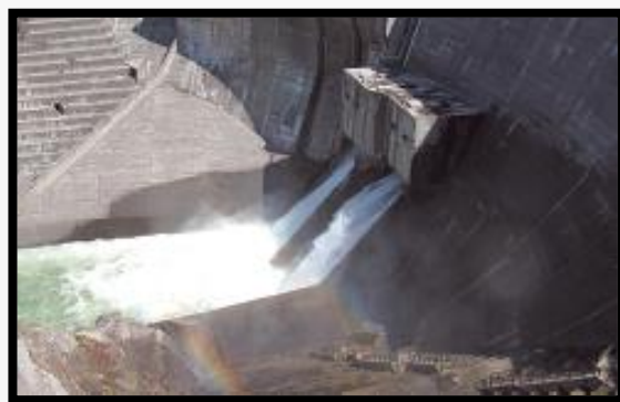
圧着方式オリフィスゲートの採用【湯田ダム】
