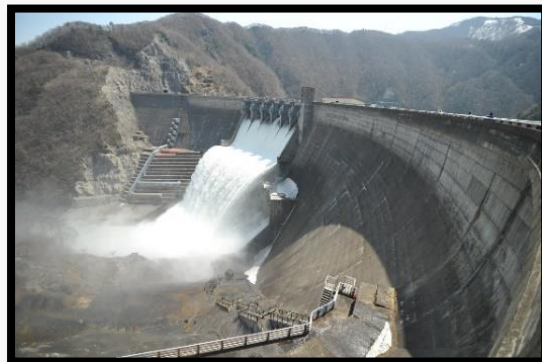
フリップバケットの採用(減勢方式)【湯田ダム】
