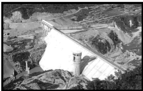
国内初のロックフィルダム【石淵ダム】
