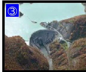
湯田ダム(西和賀町) 昭和39年11月完成(完成後57年目)
