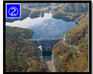
田瀬ダム(花巻市) 昭和29年10月完成(完成後67年)
