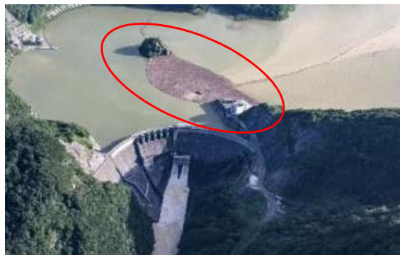
湯田ダムでの捕捉状況
