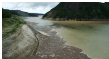
◆胆沢ダム貯水池◆ 洪水を貯め込むと同時に大量の流木も捕捉した
