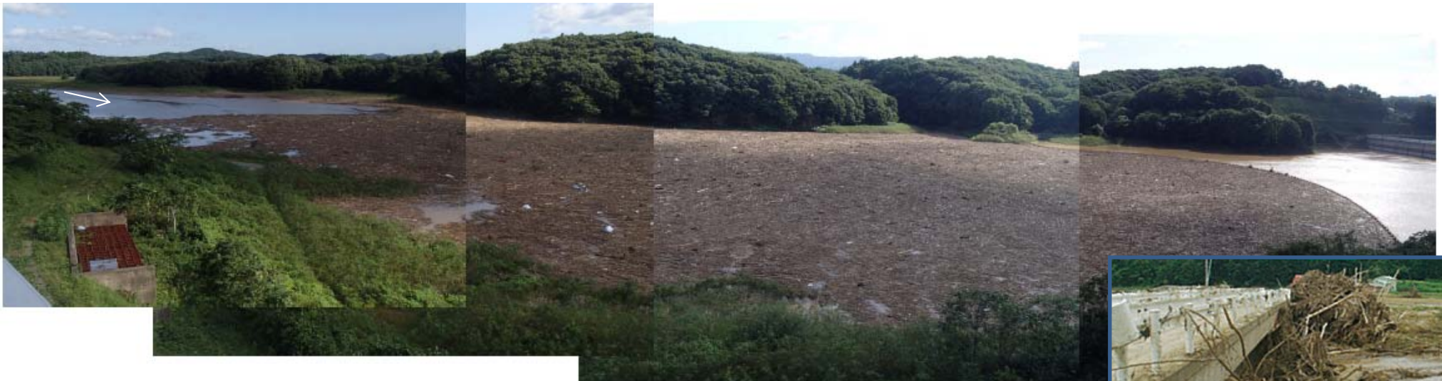
四十四田ダム流木状況（H25.9.17）
