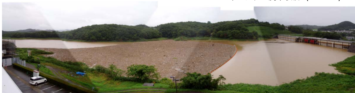
四十四田ダム流木状況（H19.9.18）
