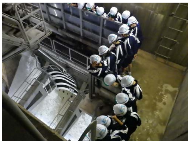
コンジットゲート見学中
