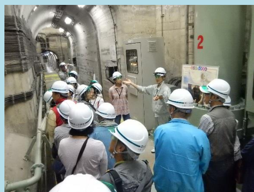
高圧放流設備見学
