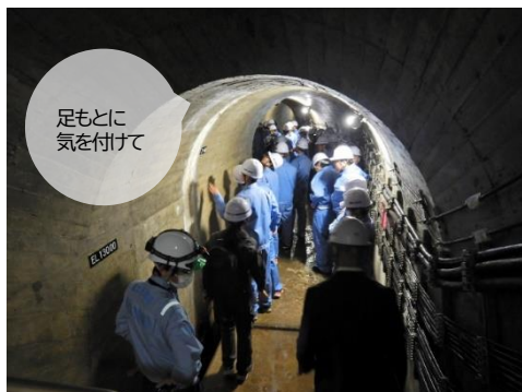
監査廊(ダムの中)です
