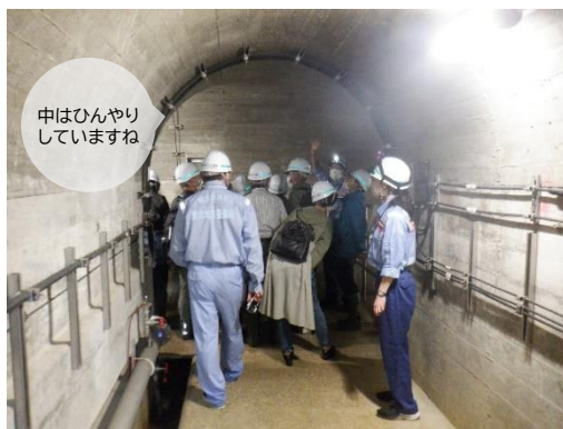
監査廊（ダムの中）です
