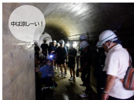
監査廊(ダムの中)です
