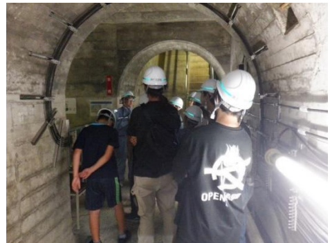
監査廊(ダムの中)です
