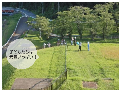
天端通路（ダムの上の通路） に向かいます
