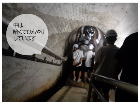
監査廊(ダムの中)です
