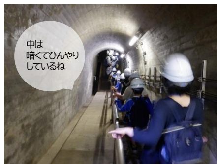
監査廊(ダムの中)です
