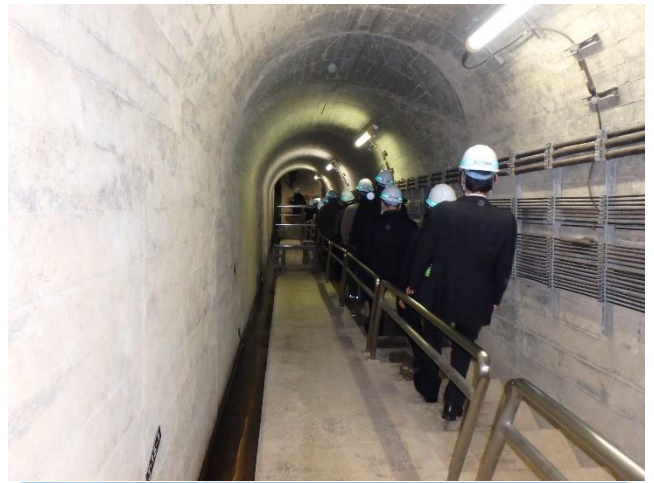
監査廊の階段
