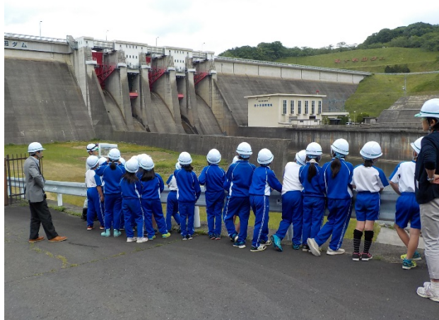
ダムを見ながら説明
