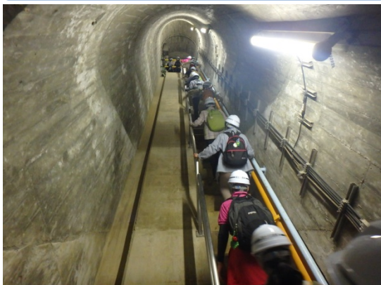
ダム内部監査廊の階段
