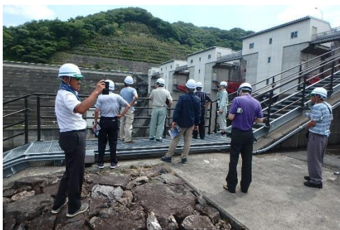
階段を上がると放流ゲートが間近に。 放流ゲートと御所発電所について説明。
