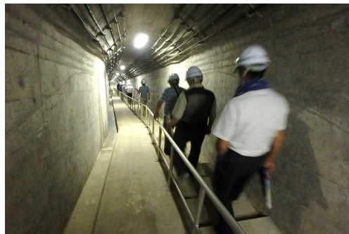
監査廊の階段を下り最深部へ
