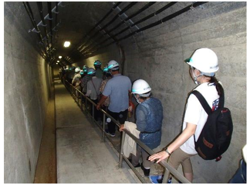
監査廊の階段を下り最深部へ 最深部では地震計など説明。
