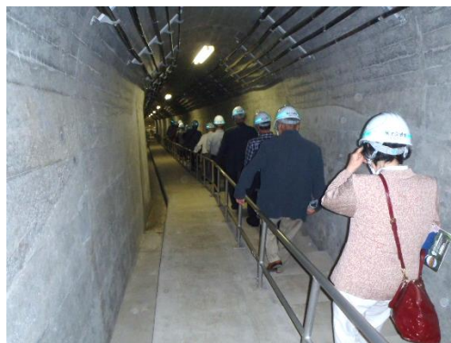
監査廊の階段を下り最深部へ
