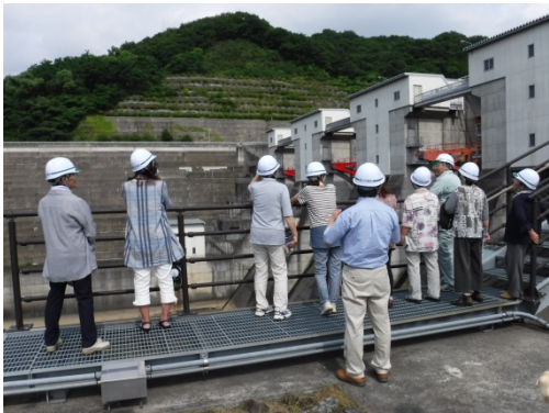
間近に見るダムゲート
