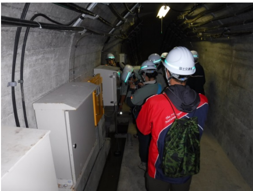
監査廊にて漏水観測について説明
