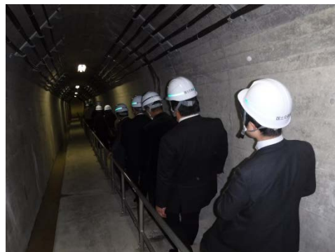
監査廊内の急な下り階段
