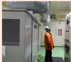
【電気通信設備点検】
