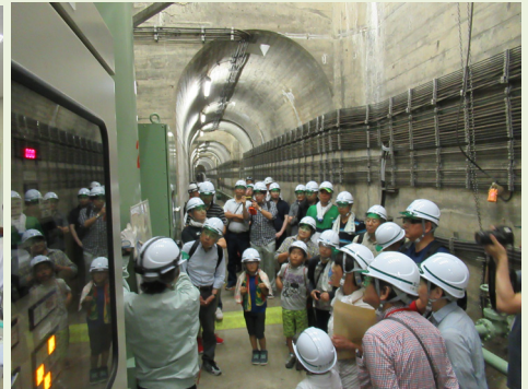
ダム内部(監査廊)の見学
