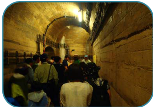
監査廊の様子
