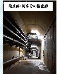
国内最大級のロックフィルダムである胆沢ダムは点検などに使う内部の通路も長大です。延長約870m、階段段数996段、最大勾配45度。温度は一年中ほぼ一定で10~12℃、真冬の外との差は20℃以上になることもあります。
