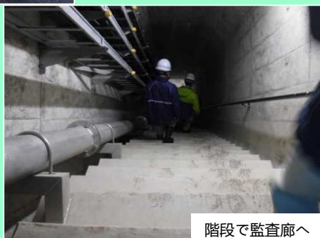
階段で監査廊へ
