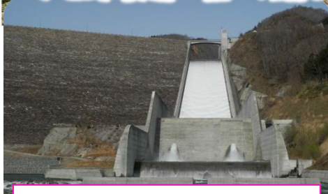
4月10日 融雪による越流 堤体下流から洪水吐きを正面に望む
