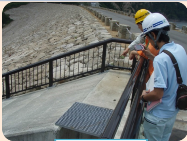
点検実施状況
