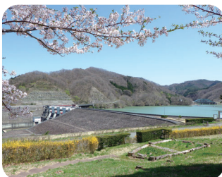
R3.4.23 御所ダム遊歩道
