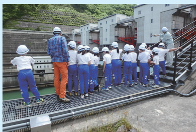
間近に見る放流ゲート
