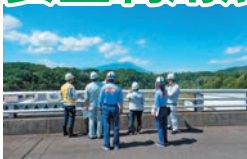
御所ダム管理所構内
