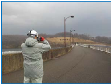
天端状況の確認
