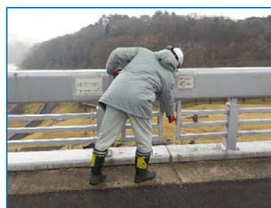
高欄の施錠確認
